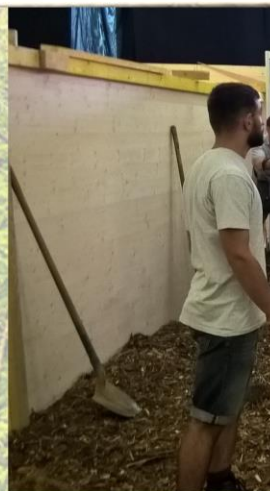
Montage de l'aménagement
